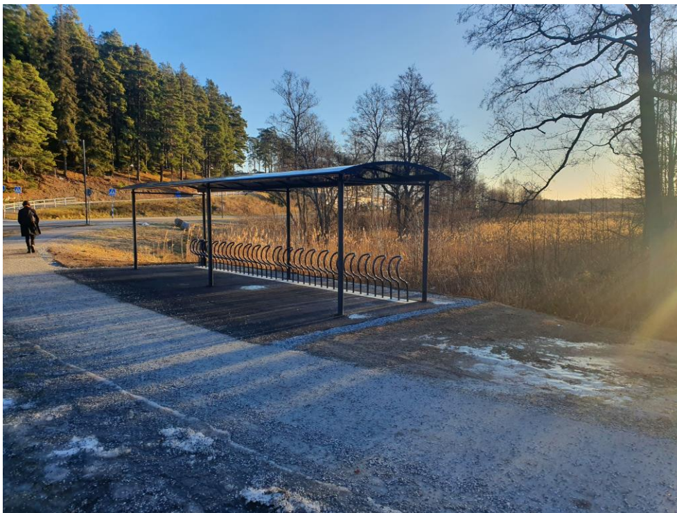
Figur 6. Ny cykelparkering vid Täljövikens busshållplats.
